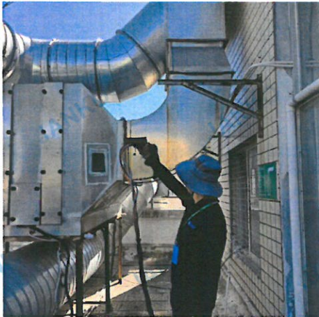
A 栋顶楼排气筒 (焊锡) 01
