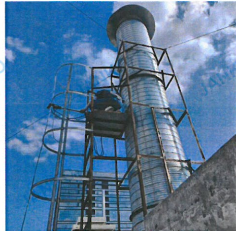
B 栋顶楼排气筒 (注塑) 04
