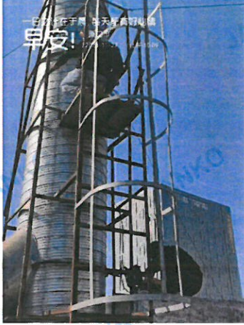
B 栋顶楼排气筒 (注塑) 02
