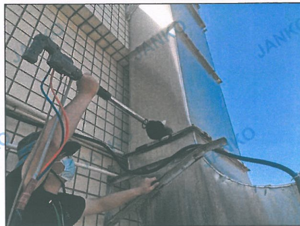
B 栋顶楼排气筒(焊锡) 02
